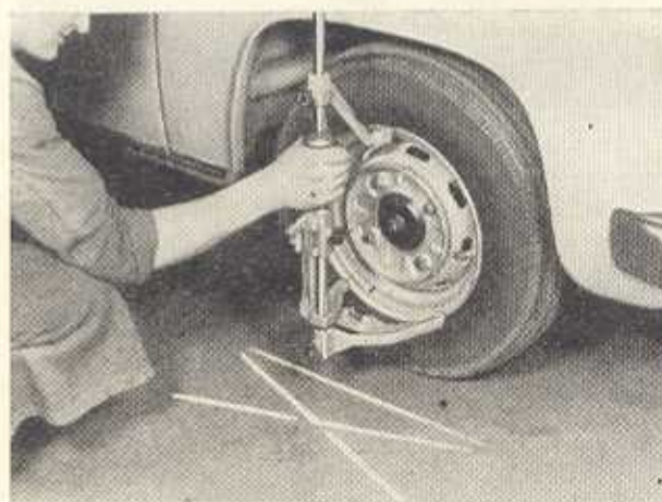
Bild F 63a und b. Messen des Nachlaufs mit Achsmeißgerät (Geradeausstellung)
